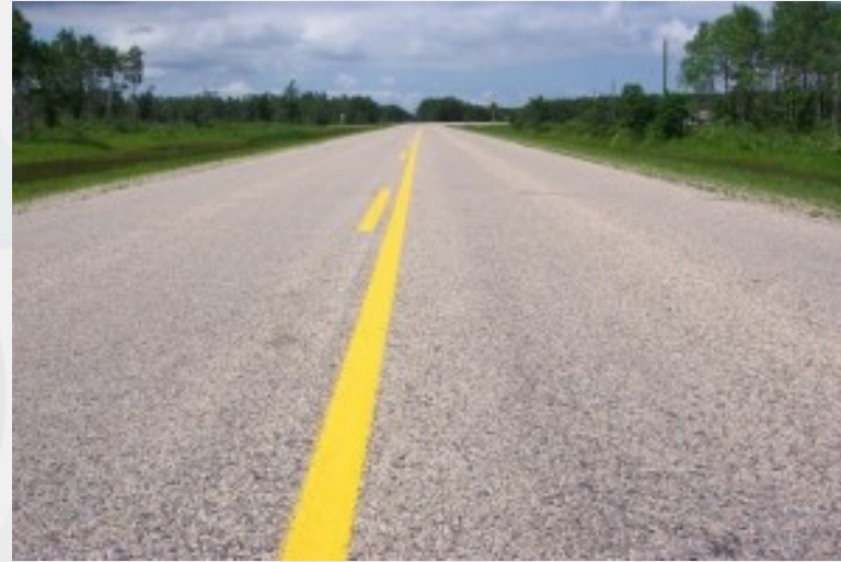
Superficie de asfalto
