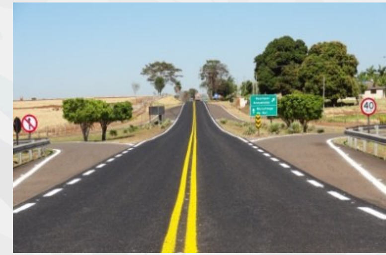
Superficie de asfalto regular
