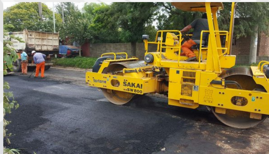
Superficie de asfalto con textura muy tersa
