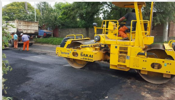
Superficie de asfalto con textura muy tersa
