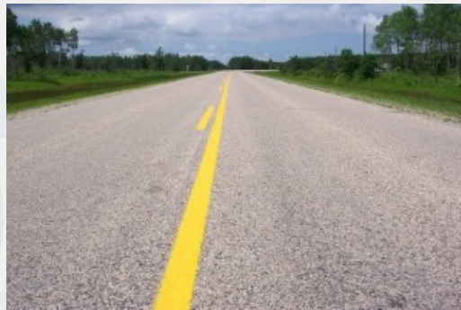
Superficie de asfalto
