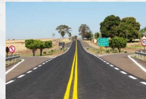
Superficie de asfalto regular
