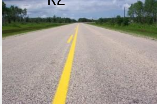
Superficie de asfalto
