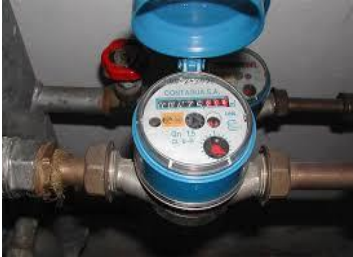
Medidor de flujo de agua
