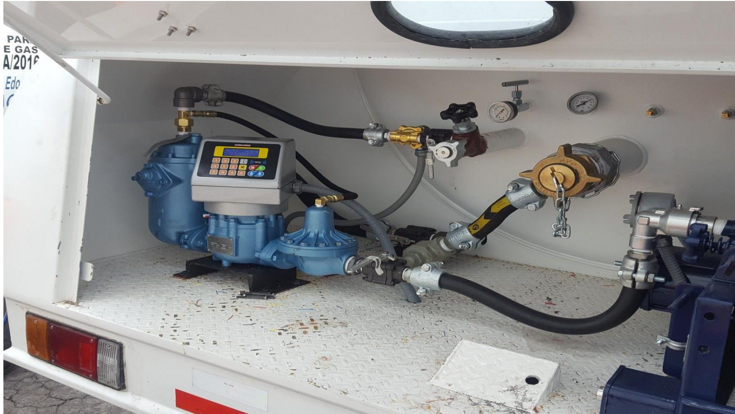
Medidor de gas estacionario
